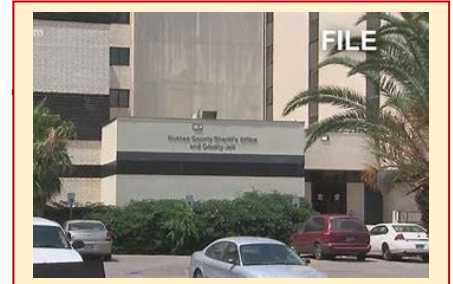
Nueces County Jail
